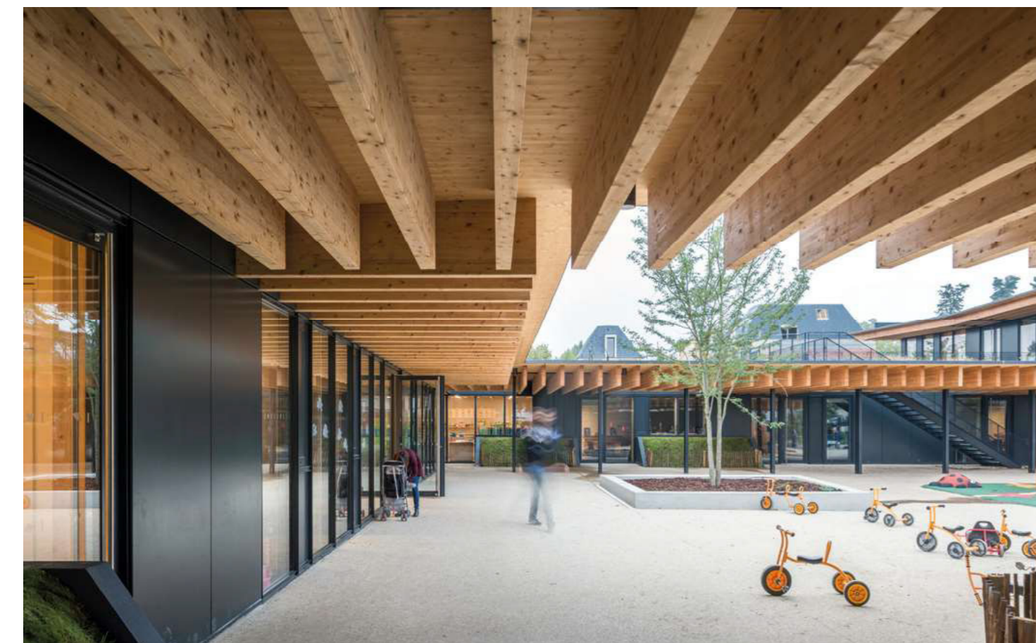
▲ Le métal anthracite s'efface derrière la présence des massives poutres d'épicéa, dont le porte-à-faux sert de préau.
