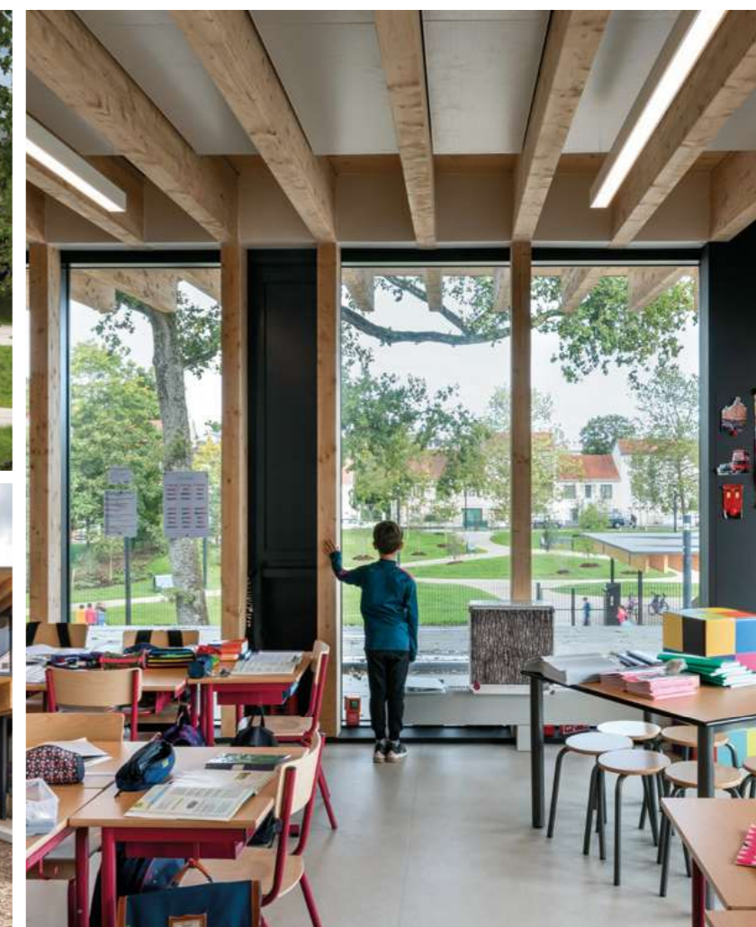
▲ Vue depuis les salles de classe de l'étage, où les portiques en épicéa sont conservés apparents.
