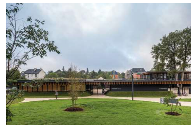
▲ Vue sur l'école depuis le haut du parc.
