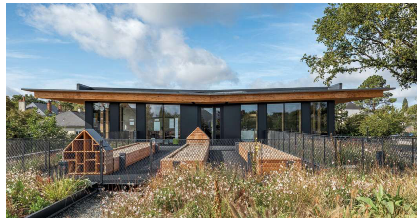
▲ La toiture-terrasse du niveau consacré aux maternelles accueille le jardin pédagogique des élèves de primaire.
