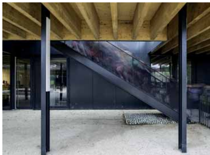
L'accès à la toiture végétalisée depuis la cour de récréation.
