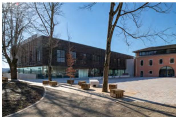
► L'habillage de la partie haute des façades de l'extension est constitué de lames de mélèze courbées, qui animent l'édifice d'un mouvement d'ondulation, évoquant la nature et l'eau.
